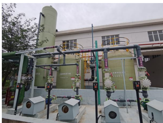
废氯处理塔及次氯酸钠循环槽
