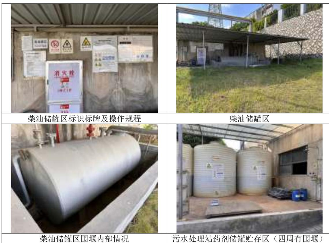
图 4-1 储罐类储存设施土壤污染防治情况照片
