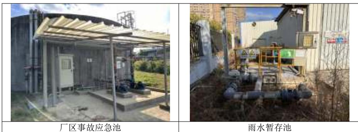
图 4-8 应急收集设施土壤污染防治设施照片
