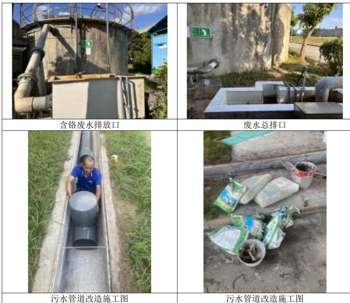
图 4-7 废水排水系统土壤污染防治设施照片
