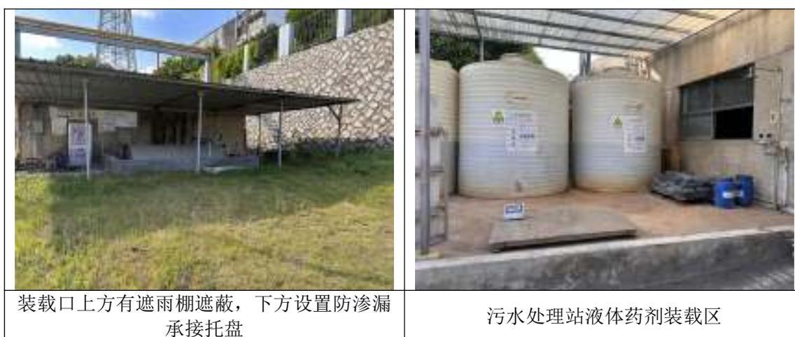
图 4-3 散装液体物料装卸土壤污染防治设施照片
