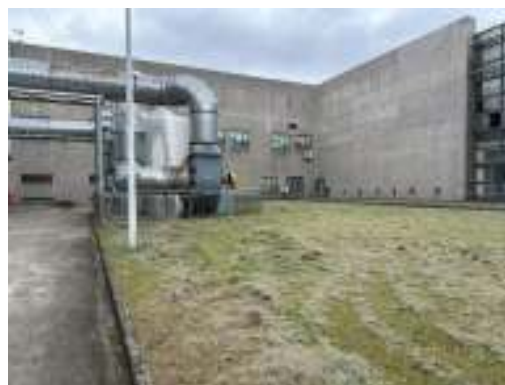
涂饰车间西侧
