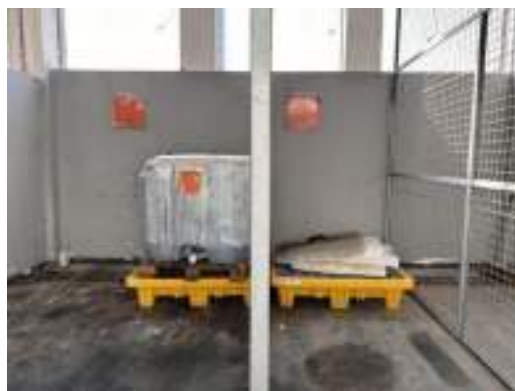
危废仓库内部涂有防渗涂层
