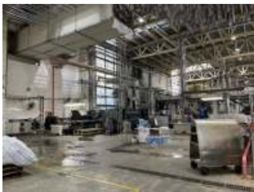
车间内部地面均已硬化
