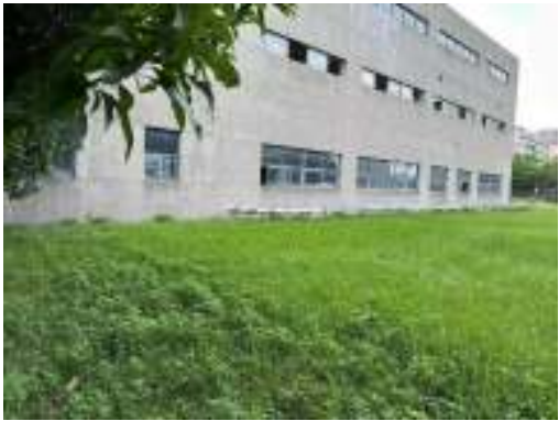
污水处理站集水井旁、污泥间旁
