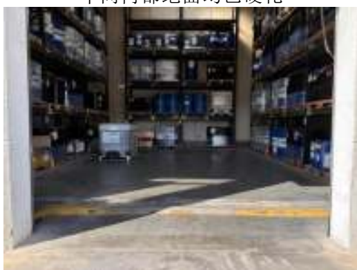
化学品仓库地面涂有防腐层
