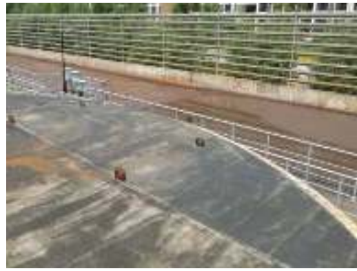
污水处理站（局部）
