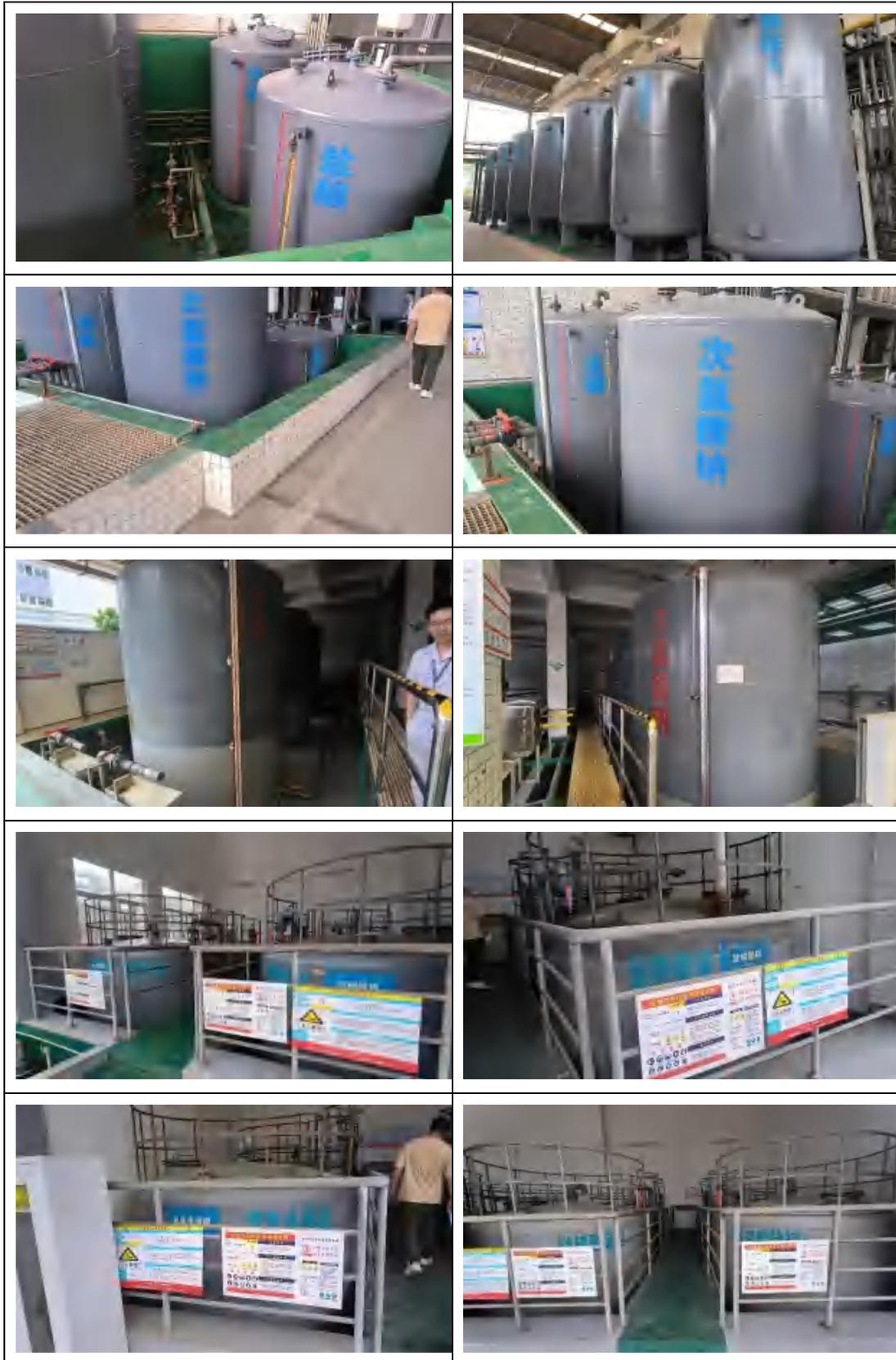
图 3.3-2 厂区地下及半地下储罐照片
