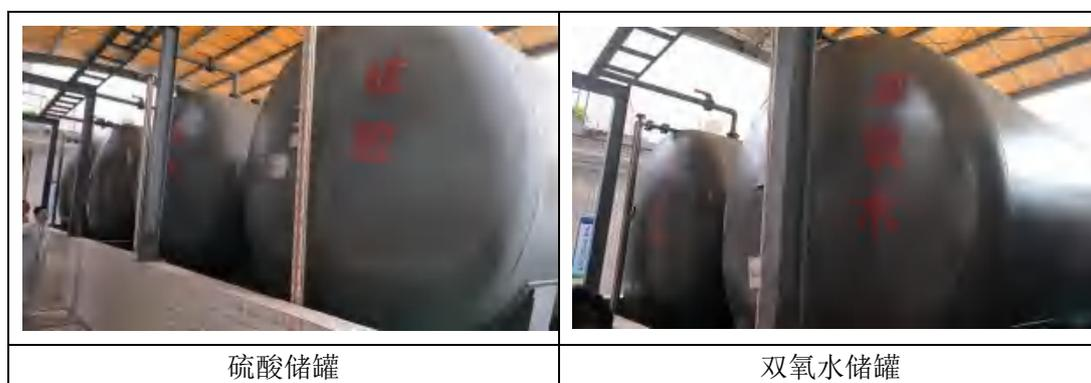
图 3.3-3 厂区接地储罐照片
