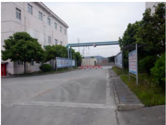
厂区内部道路
