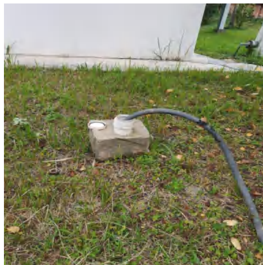
地下水点位D03洗井
