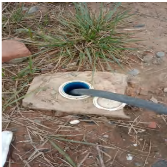
地下水点位D04洗井
