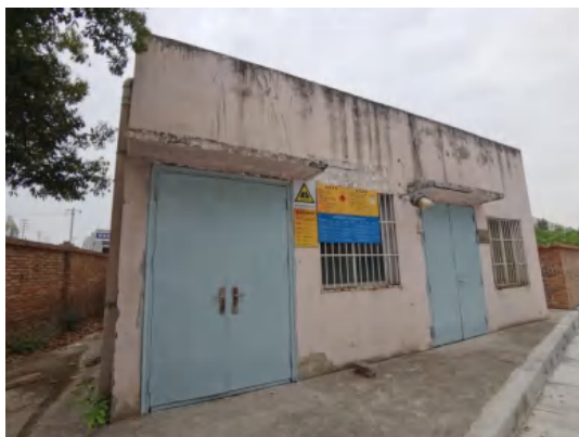
危废暂存间（停用）
