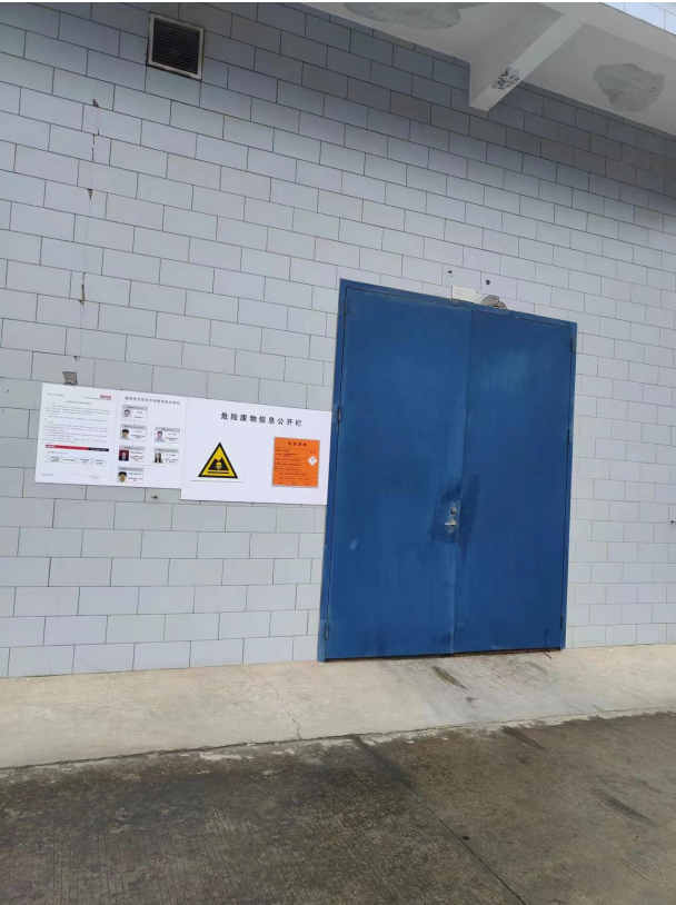
危险废物暂存间
