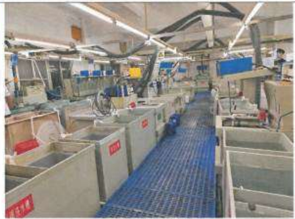
1号楼电镀车间
