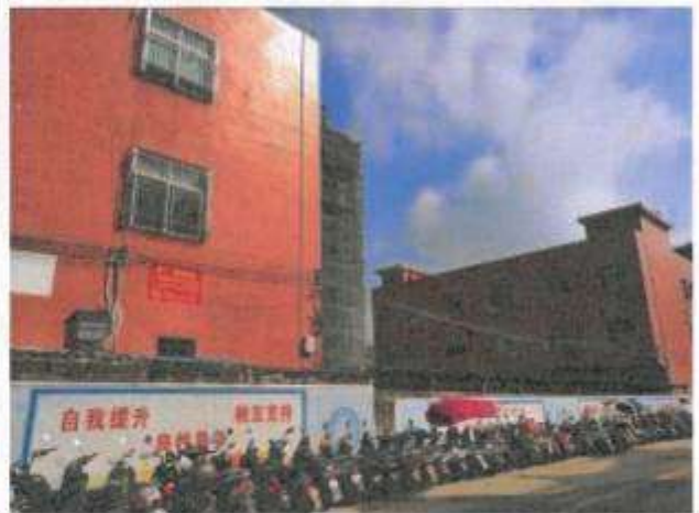
西面 其他工厂厂区-2
