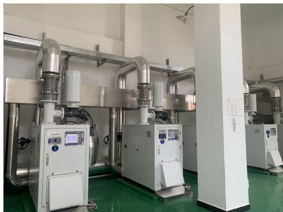
21. 风机隔声减振措施
