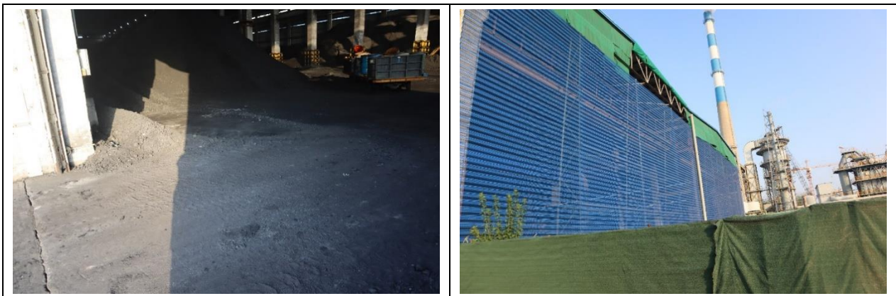
图 4.3-4 煤库现场照片
