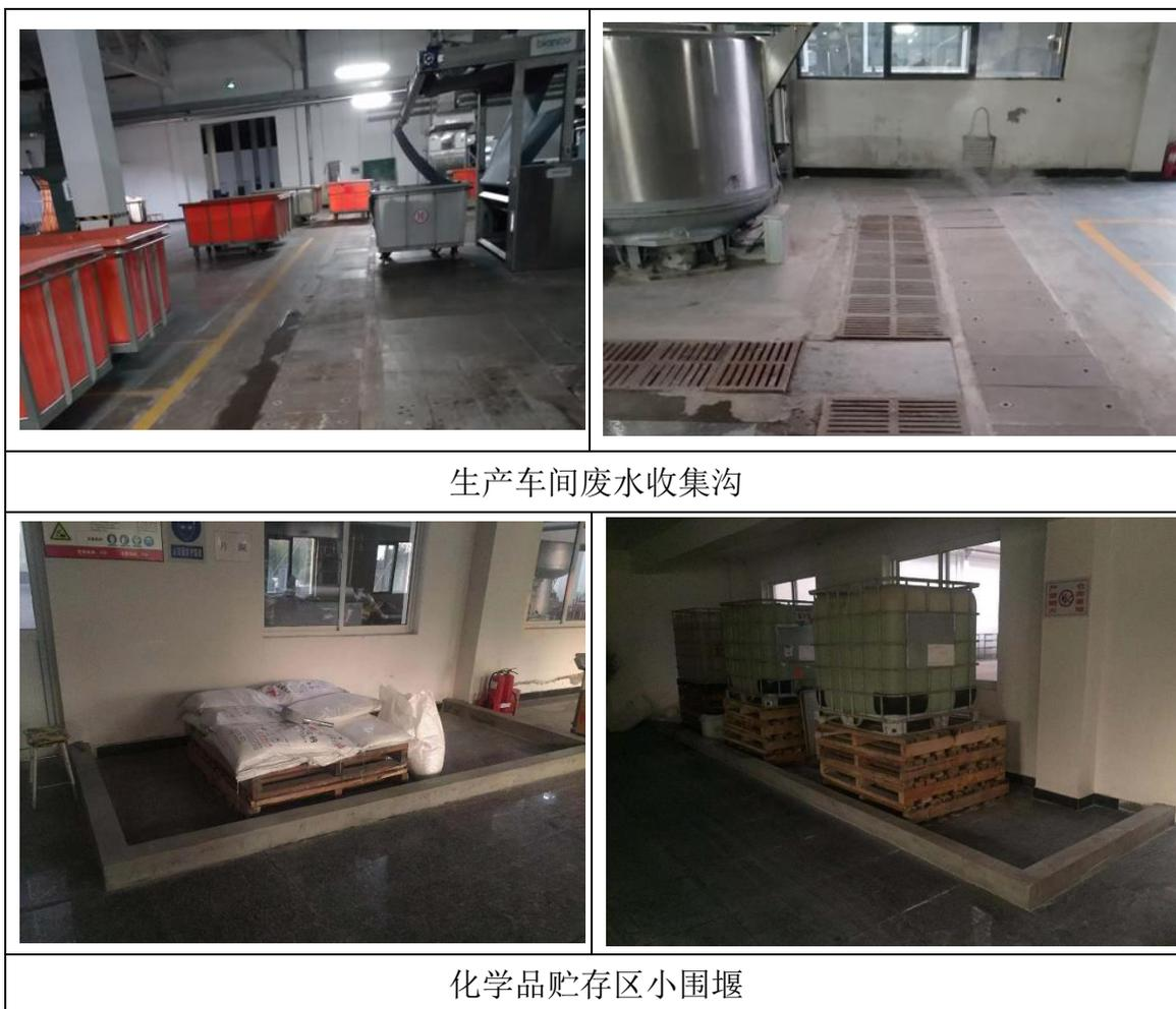
图4.2-2 废水收集系统及围堰建设情况
