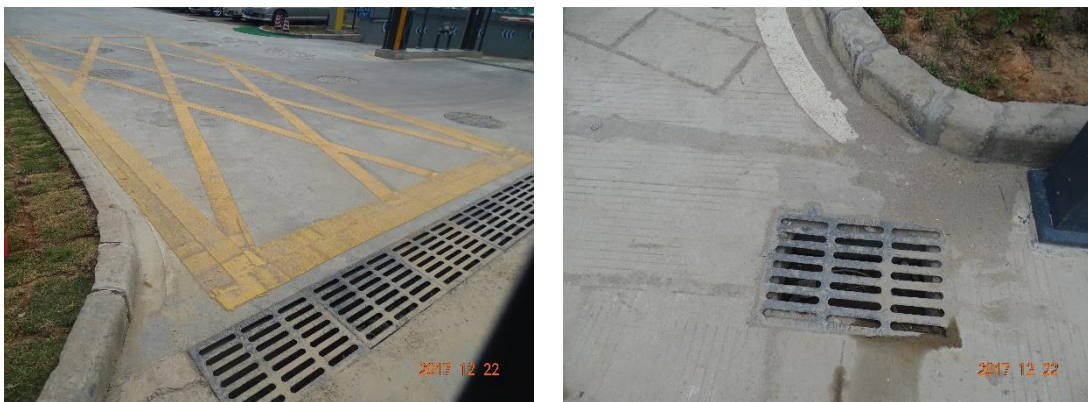
图 4-1 水土保持工程措施
