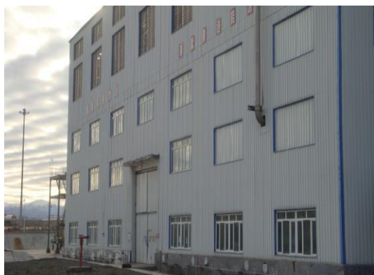
全封闭压缩机厂房 1
