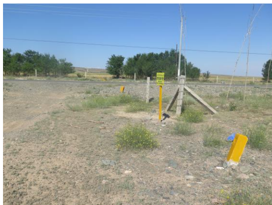
18.9km 管线周边植被恢复情况
