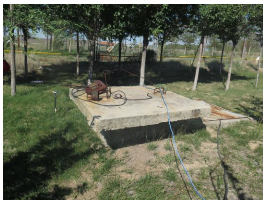
厂区内污水收集池
