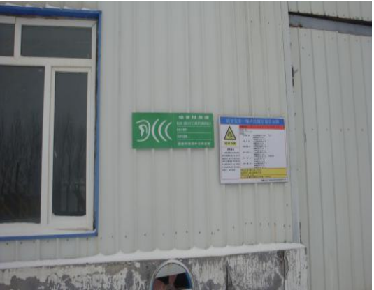
压缩机厂房噪声排放标识表标牌
