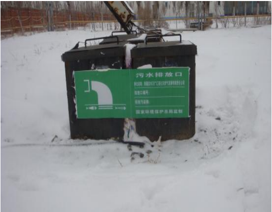
废水排放口标识标牌
