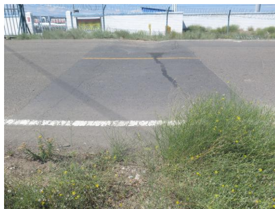
首站道路恢复情况
