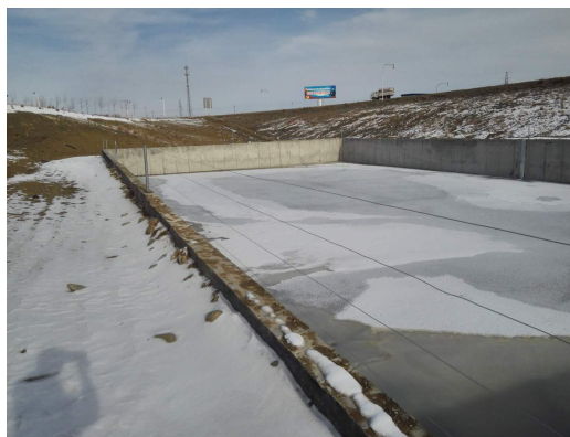
污水收集池防护栏
