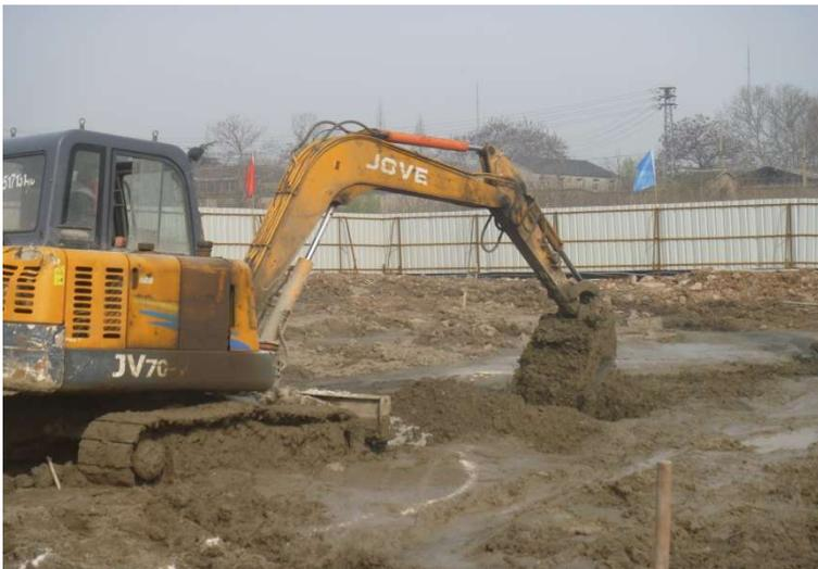
图 6.1-1 固化稳定化施工作业情况
