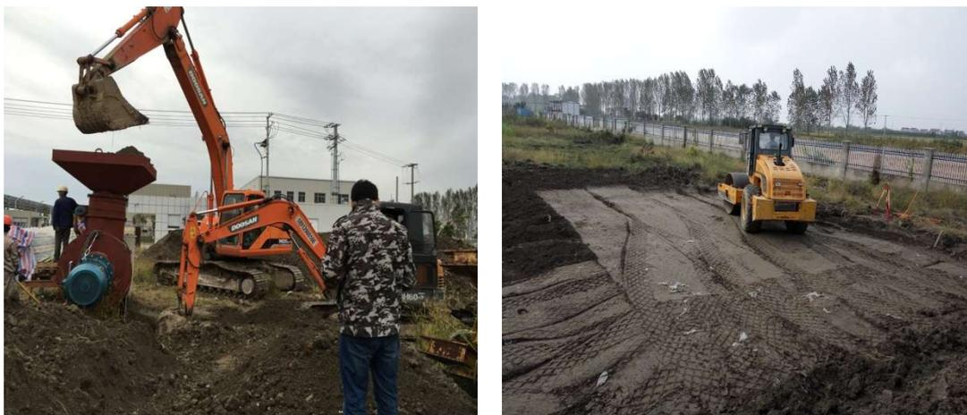
**修复效果：**SS-E 异位固化稳定化修复后，土中重金属浸出无检出，满足修复目标要求。
